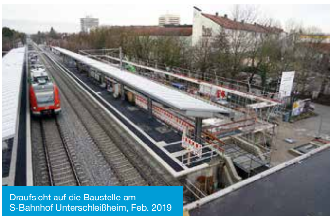
Für den stufenlosen Einstieg in die S-Bahn mussten die Bahnsteige vollständig erneuert werden.
